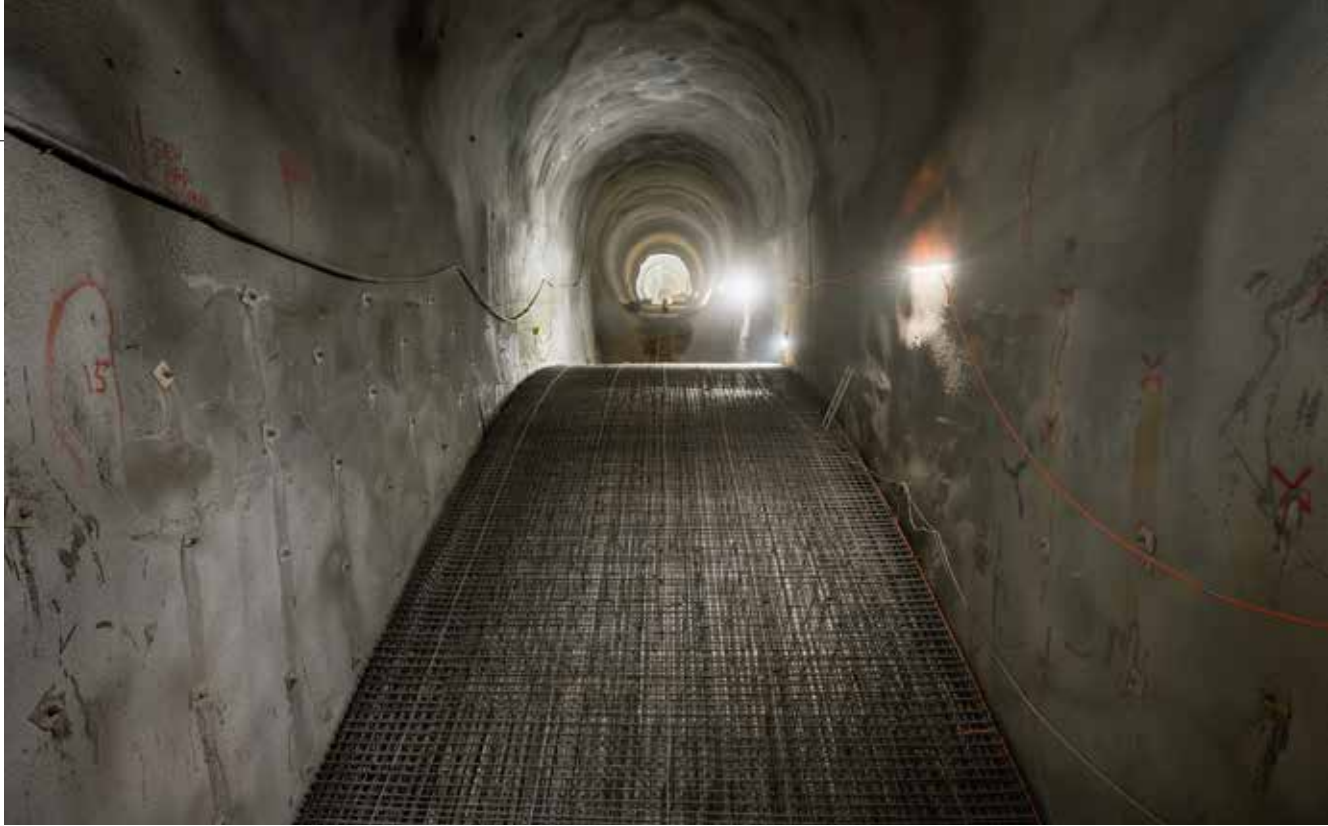
Slika 5: Armatura ločne konstrukcije
