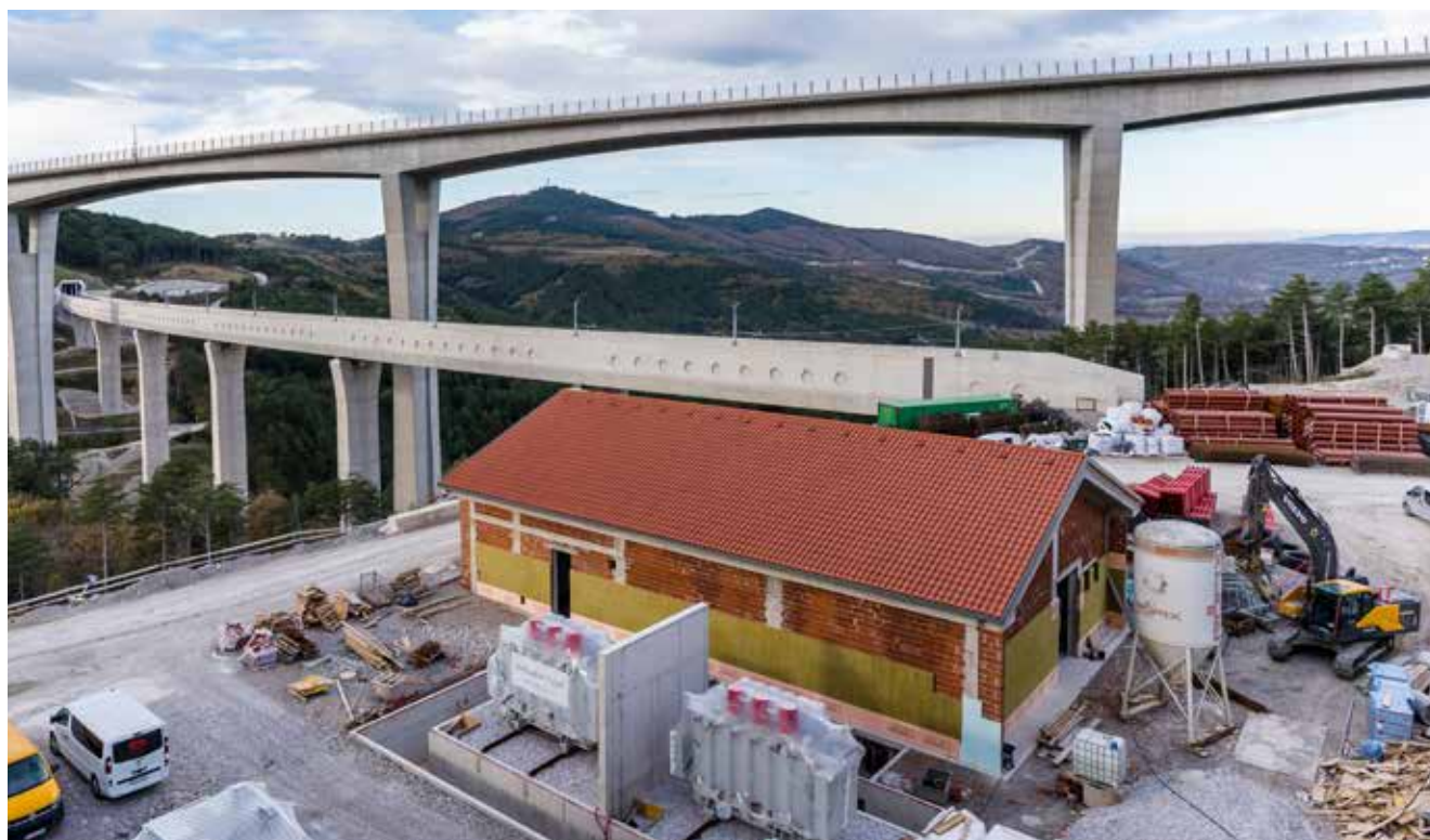
Objekt ENP Črni Kal na platoju T2 - Koper
