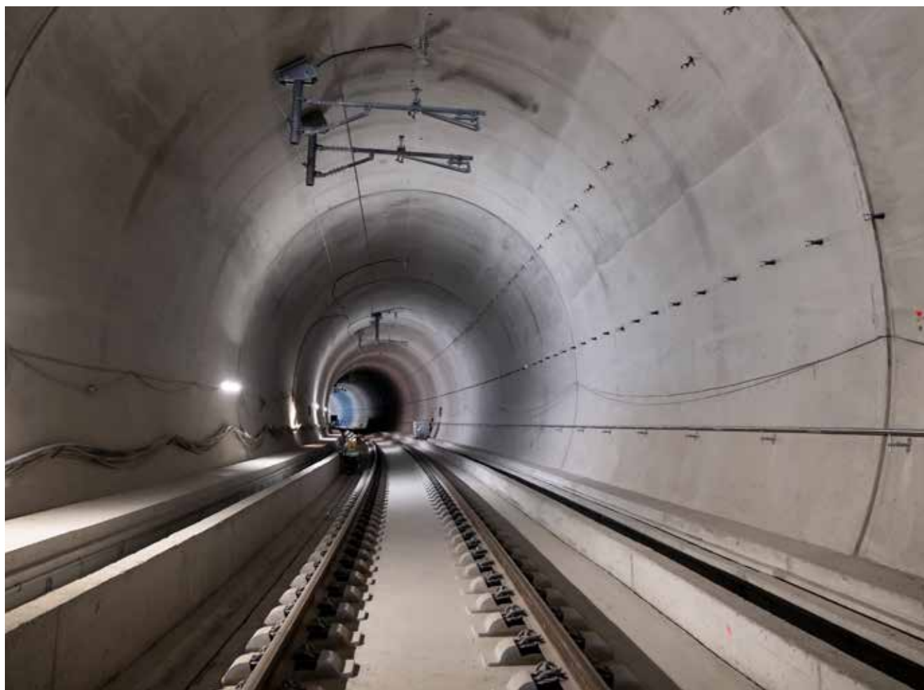
Slika 2: Tir na togi podlagi v predoru T8
