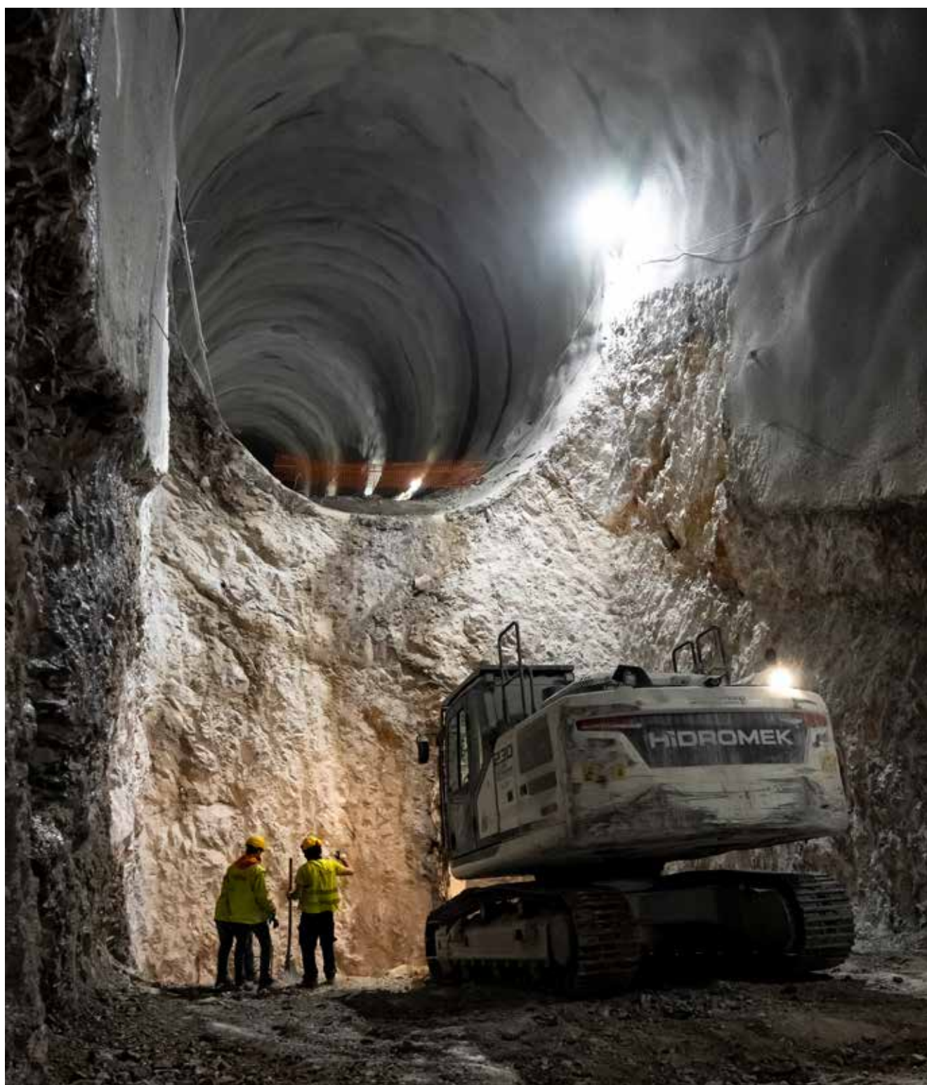
Slika 6: Izkop za temelj
