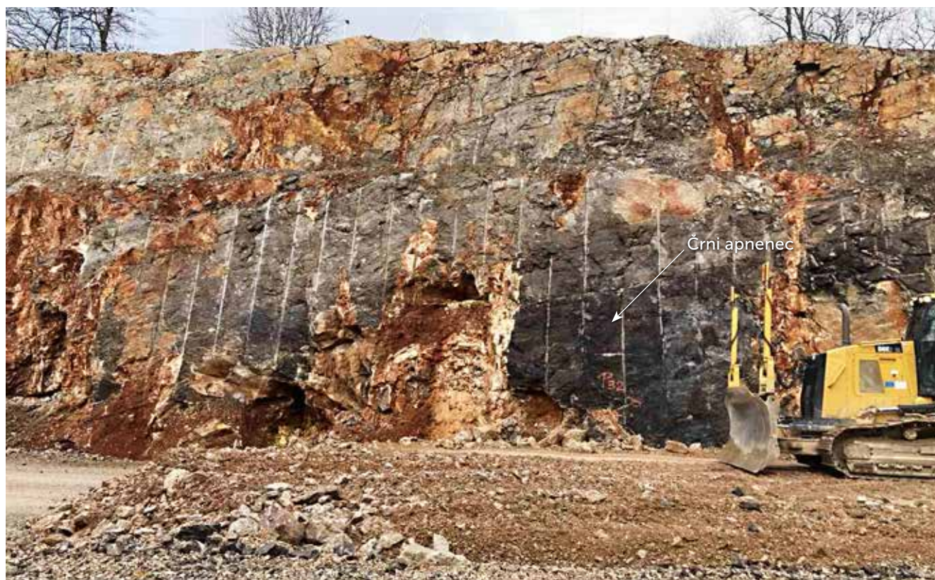
Slika 1: Črni Liburnijski apnenec v predkopu predora Lokev (T1) - Divača, marec 2025. Vir: Arhiv ZAG
