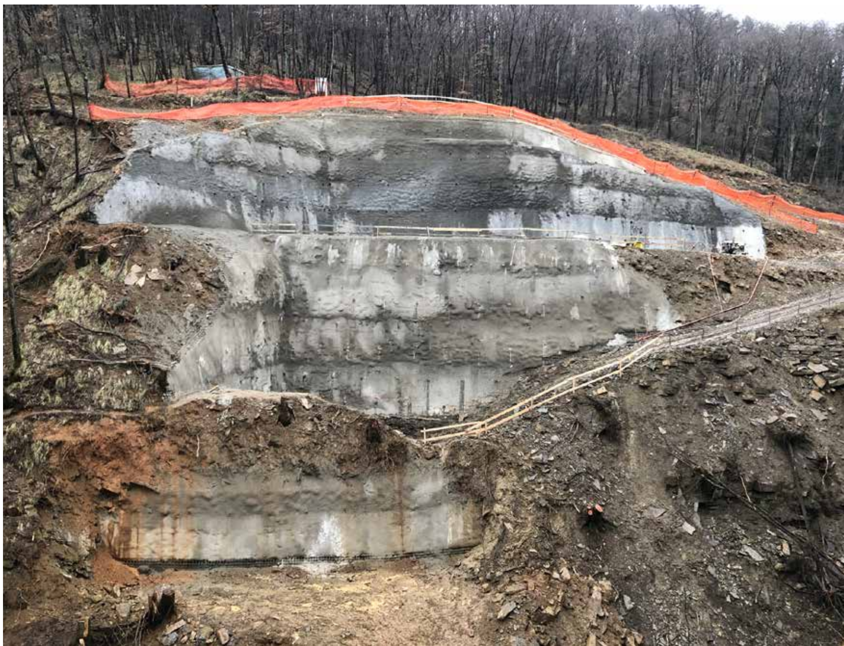
Slika 1: Več kot 25 m globok vkop za krajni opornik viadukta Glinščica pri predoru Lokev (T1)
