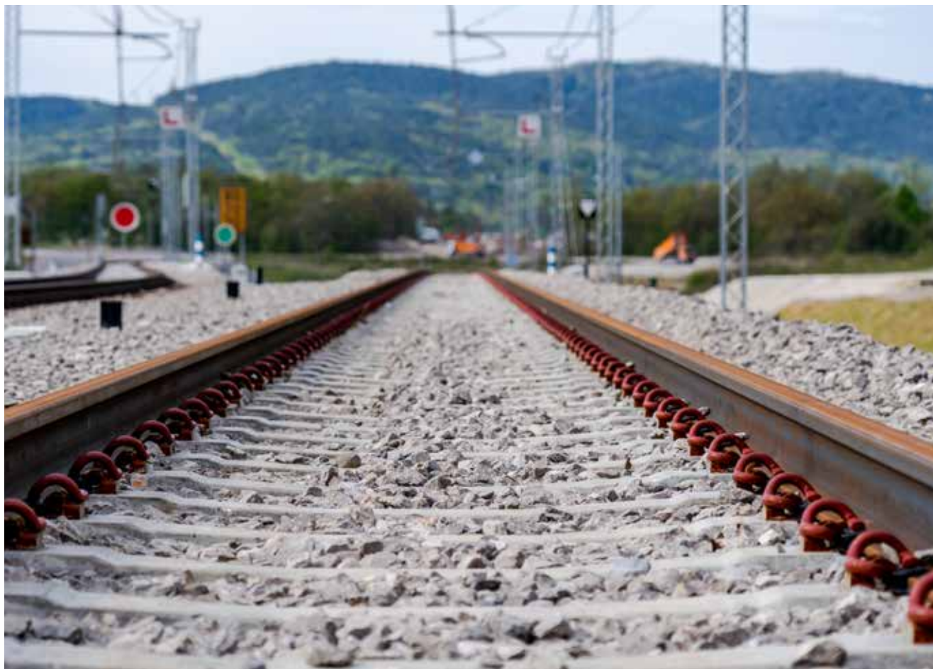
Slika 1: Tir na gramozni gredi na novi progi pri Divači
