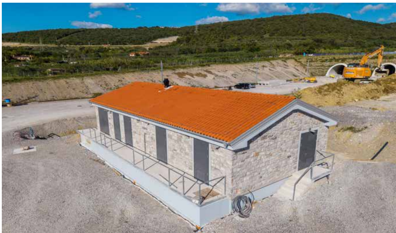
Transformatorska postaja na platoju T8 - Koper
