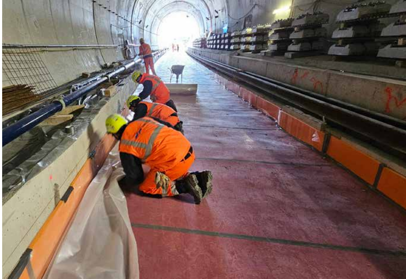
Slika 3: Polaganje materiala MSS pred vgradnjo tira v predoru Škofije (T8) - Dekani
