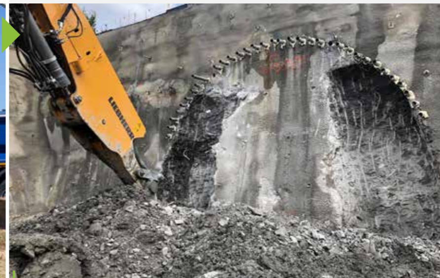
September 2021 Pričetek izkopa predorov
