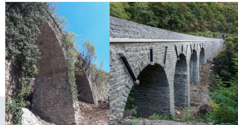
VIADUKT POD NASIRCEM PRED IN PO OBNOVI
