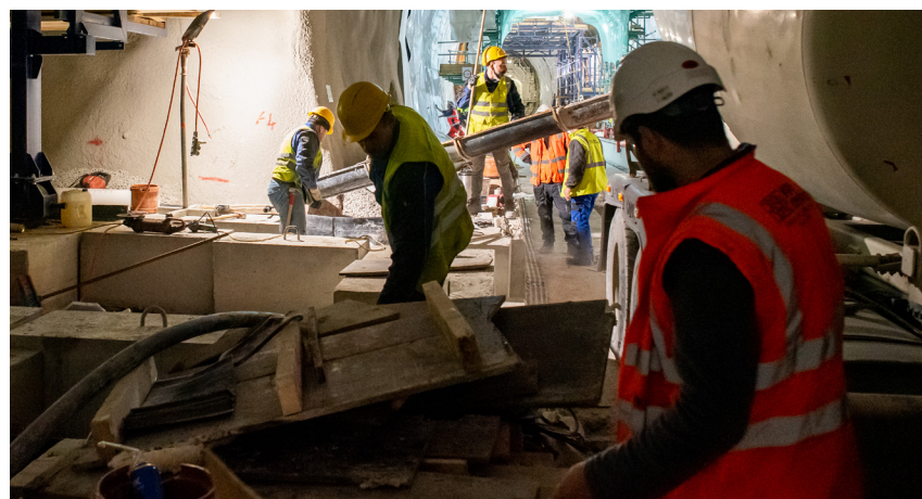
Betoniranje temeljev notranjega oboka
