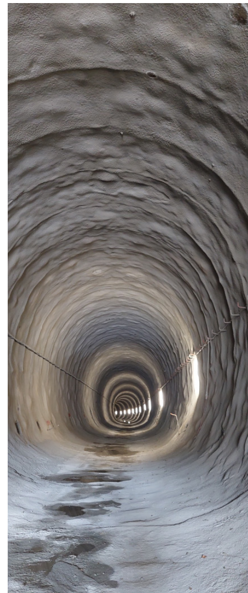
Izgled predora po izvedbi izkopa in osnovnega podpiranja – predor je s tem pripravljen za začetek izvedbe notranje obloge
