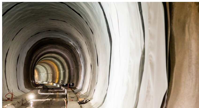
Izveden sistem hidroizolacije predora
