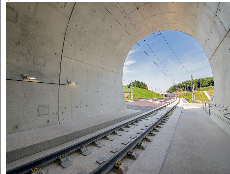
Vgrajen sistem RHEDA 2000 na železniški progi
