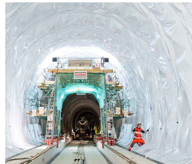
Izvedba hidroizolacije predora s pomočjo montažnega voza
