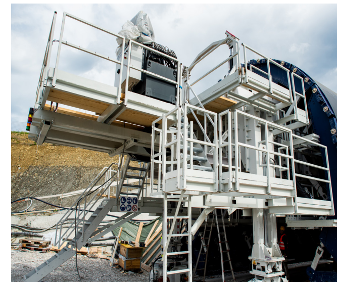
Sestavljen opažni voz pred predorom
