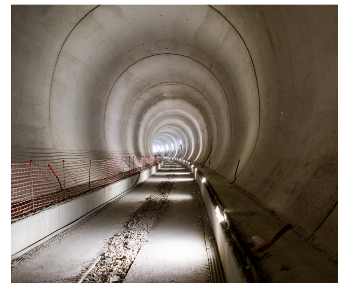
Izgled predora po izvedenem sistemu notranje obloge
